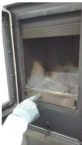
les 3 plaques du système de passage d'air
