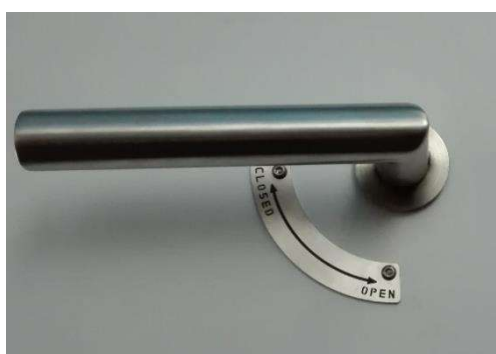
Levier du clapet des fumées vers fermé (position horizontale)
