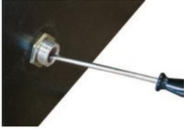
Dès que la température chute en dessous de 75 °C environ, le limiteur de température de sécurité peut être déverrouillé mécaniquement :
